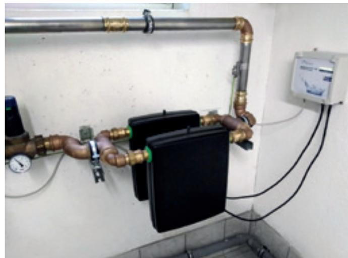
Abb.: Parallelschaltung mit zwei U-Rohren
